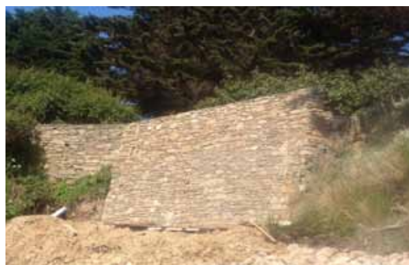
Travaux réalisés à la falaise du chemin de la Gargourite
