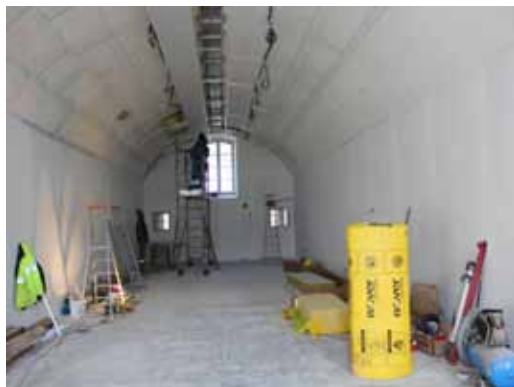
Travaux de la salle 2
