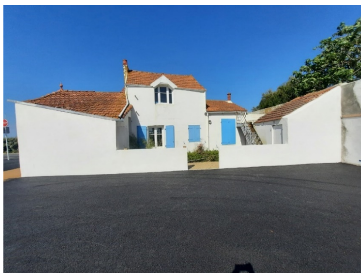
Photographie du bâtiment (vue depuis le parking Neptune)
