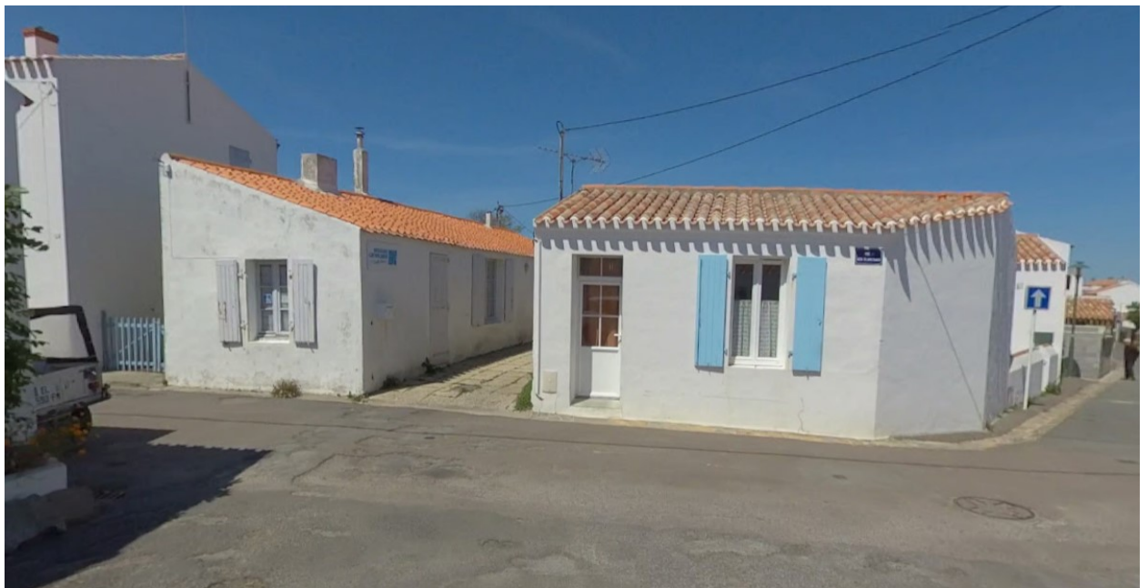
Photographie du bâtiment (façades Ker BLANCHARD) – Vue depuis la rue du Puits Mulet
