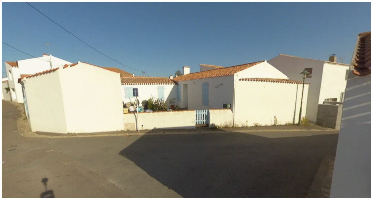
Photographie du bâtiment (façades COURSEAU) – Vue depuis la rue du PARADIS
